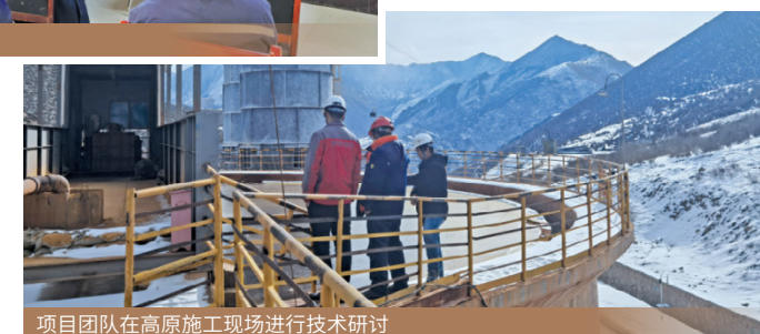
项目团队在高原施工现场进行技术研讨
